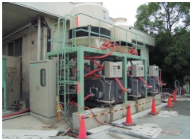
稼働中の加熱吸引法装置
